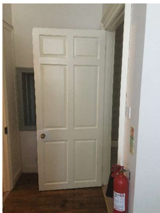
5. Door DG6 (existing)
