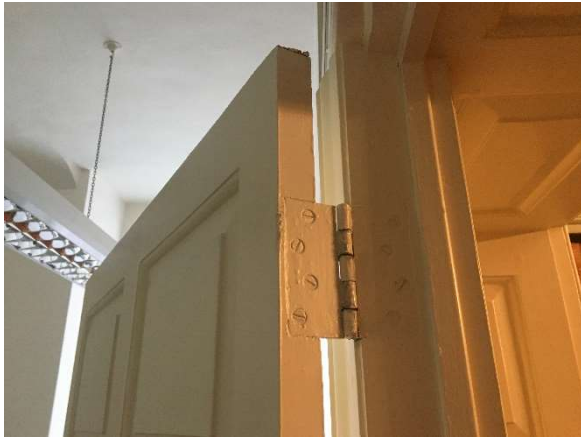
1. G/F door DG4
